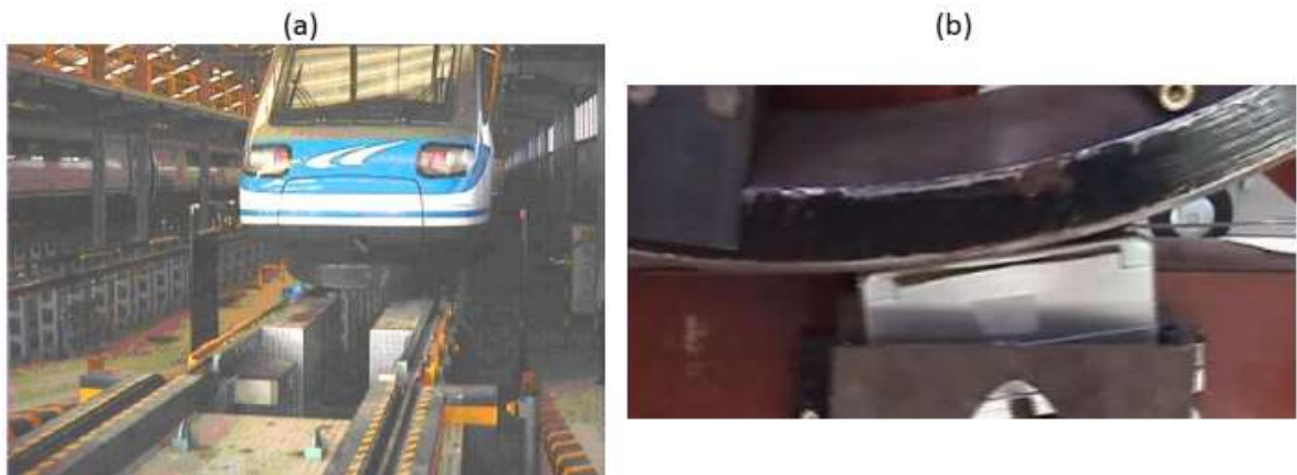
Figura 73: (a) Instalación del sistema para la detección de defectos superficiales en la banda de rodadura. (b) Transductor piezoeléctrico utilizado por el sistema para generar y recibir ondas superficiales.
