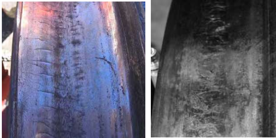
Figura 23: a) Fisuras en las zonas 1 y 3. b) fisuras estables en toda la banda de rodadura,[19, 20],
