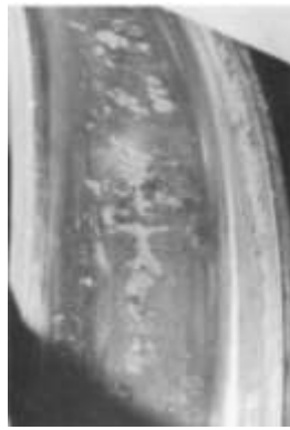
Figura 52: Foto de defecto spalling, [22].
