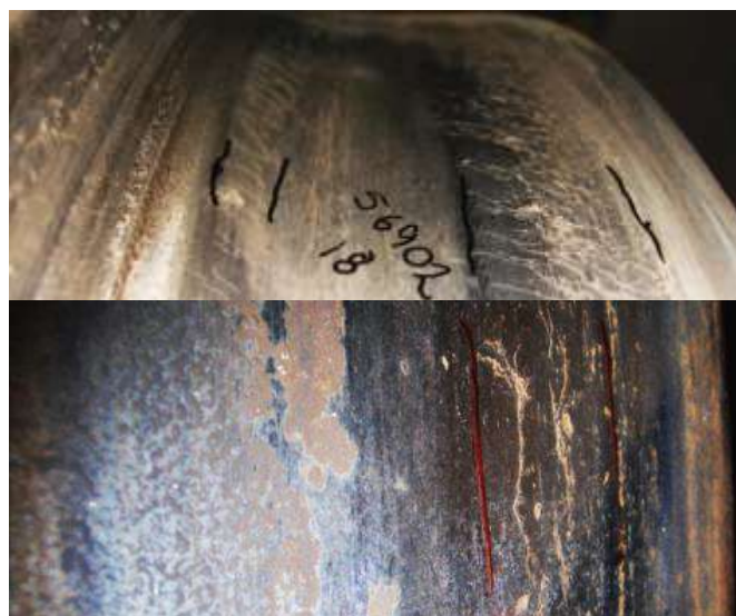
Figura 24: Ejemplos de defectos RCF en la zona 4. Se observa defectos de fatiga por contacto en otras zonas, [21].
