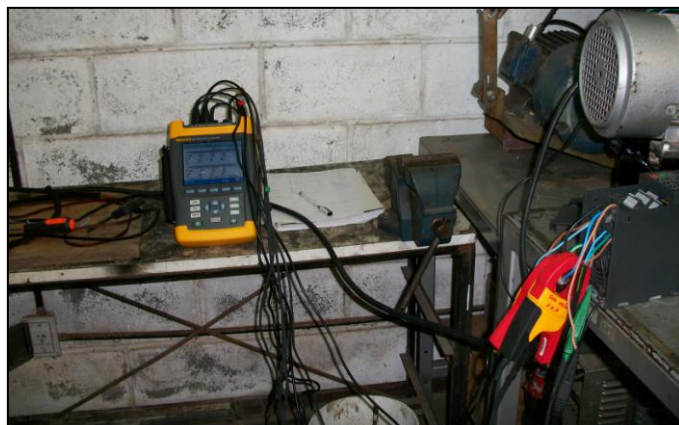
Medidas, en banco de ensayos, de variables eléctricas con medidor de calidad de energía Fluke 435
