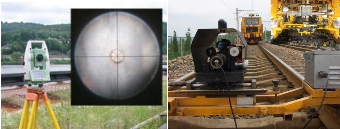
Figura 41. Izquierda: Sistema de topografía mediante punto de referencia. Derecha: En la parte del frente se observa el vehículo satélite y en fondo el vehículo de registro.
