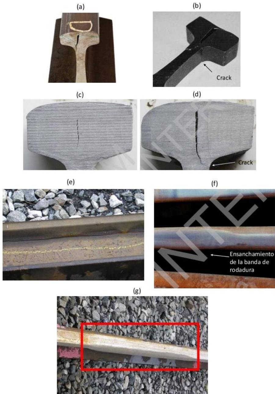
Figura 42. Separación vertical de la cabeza. (a) y (d) [3] defectos grandes; (c) [3] defecto medio; (b) [3] fractura; (e) [4] fisura entre la cabeza y el alma con sanfrgado; (f) [3] ensanchamiento de la banda de rodadura; (g) [4] descoloración oscura en la zona de defecto.
