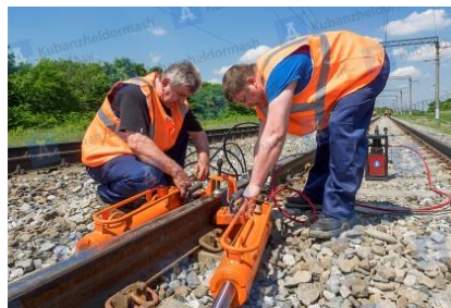
Figura 46. Tensionado hidráulico de rieles para ajustar la apertura entre los rieles.
