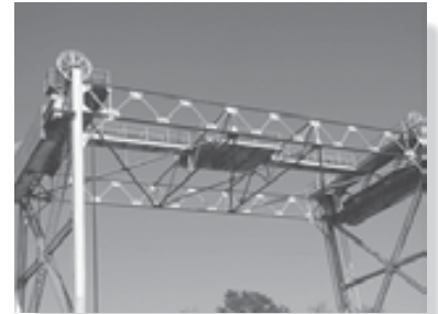
En la construcción de estas armaduras Warren, es evidente el uso de placas de unión metálicas.
