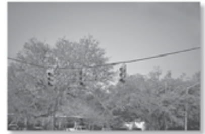
Cada uno de los segmentos de cable permanece casi recto cuando soporta el peso de estos semáforos.
