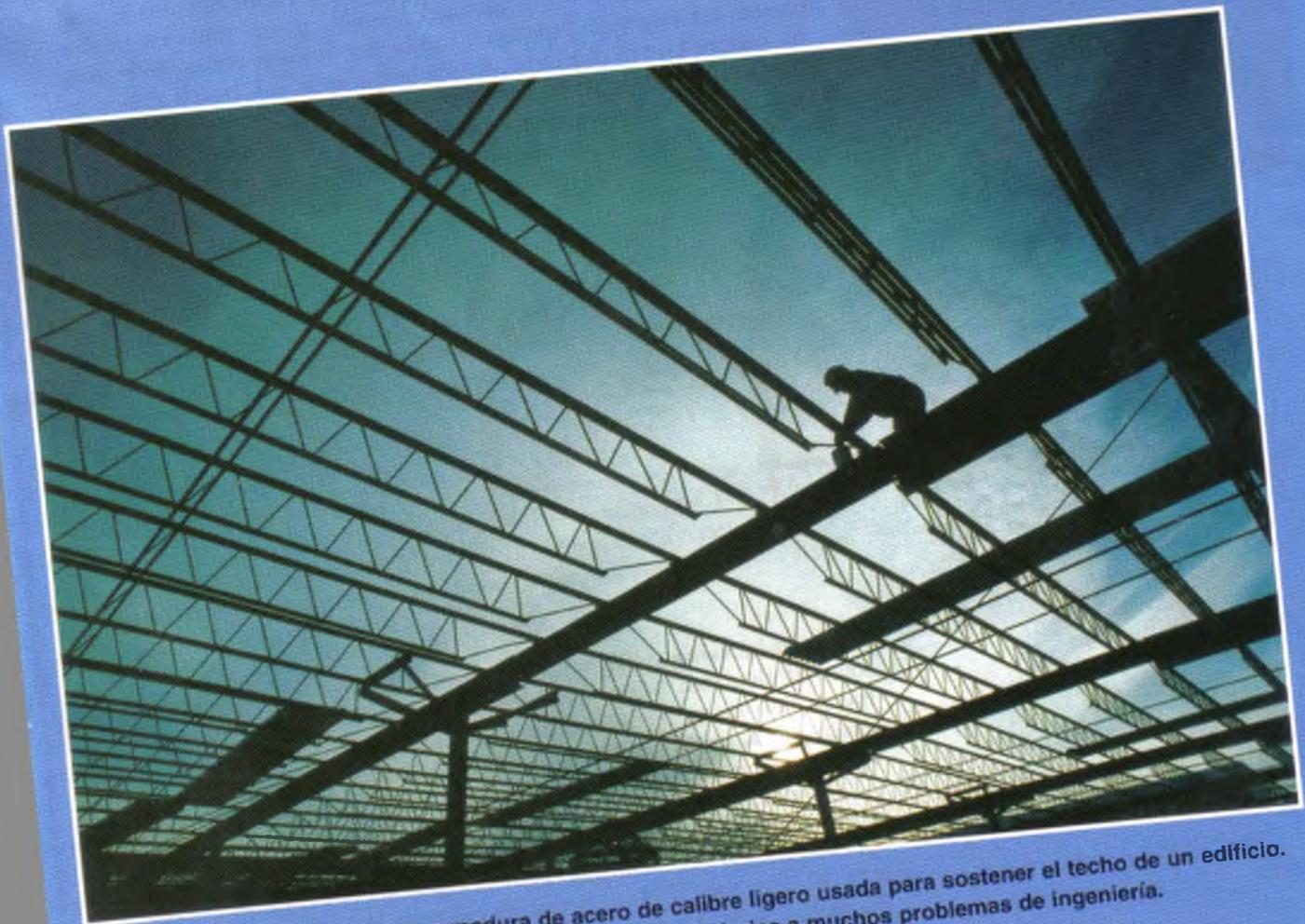
En la fotografía se muestra una armadura de acero de calibre ligero usada para sostener el techo de un edificio. Las armaduras proporcionan una solución práctica y económica a muchos problemas de ingeniería.
