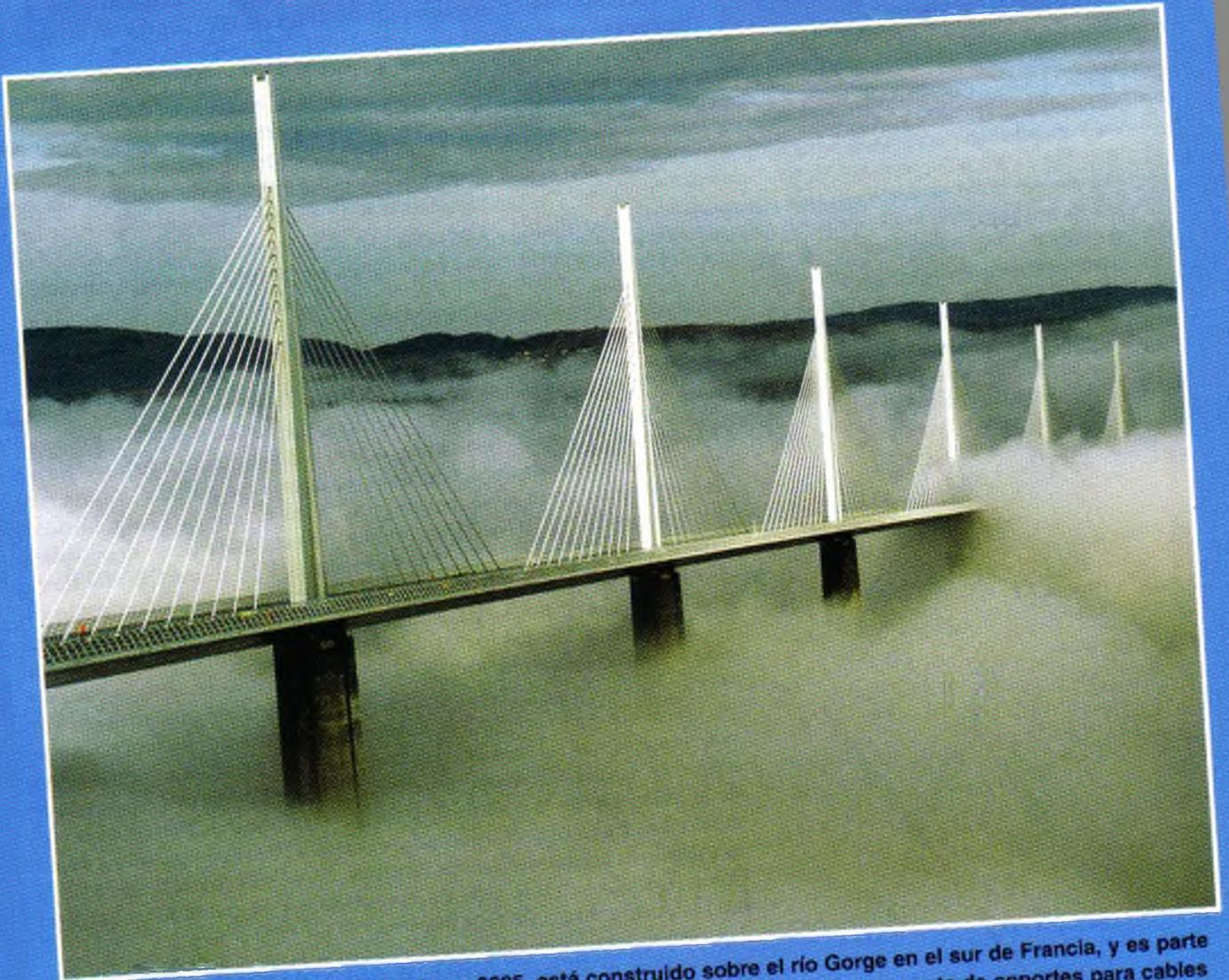
El Grand Viaduc de Millau, terminado en 2005, está construido sobre el río Gorge en el sur de Francia, y es parte de una nueva ruta entre París y Barcelona. El puente mide 2.46 km de longitud y consta de soportes para cables tensores y pilares que se elevan sobre la superficie del río hasta 245 y 335 m, respectivamente.
