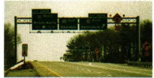
**Fotografía 3.5** Las fuerzas paralelas del viento que actúan sobre los señalamientos de la carretera, pueden reducirse a una sola fuerza equivalente. La determinación de esta fuerza puede simplificar el cálculo de las fuerzas que actúan sobre los soportes del marco que sostiene los señalamientos.
