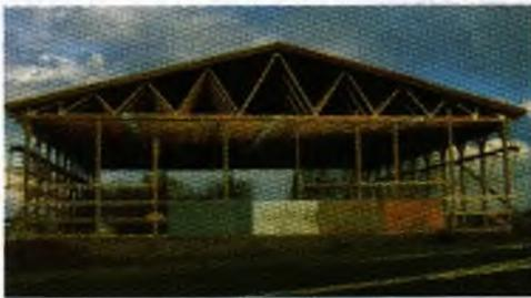
**Fotografía 6.3** Las armaduras para techo, como las que se muestran en la foto, requieren apoyo sólo en los extremos. Gracias a esto es posible realizar construcciones con grandes áreas libres de obstáculos en el piso.
