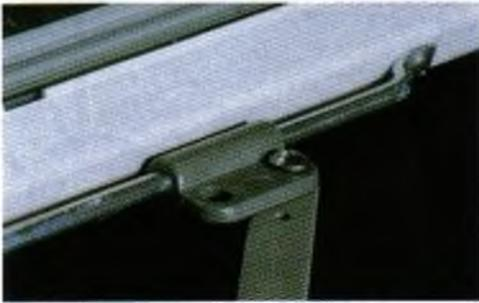
**Fotografía 4.3** Cuando el eslabón del mecanismo de apertura del toldo para ventana se extiende, la fuerza que éste ejerce sobre el deslizador produce una fuerza normal aplicada sobre la barra, lo que causa que el toldo se abra.
