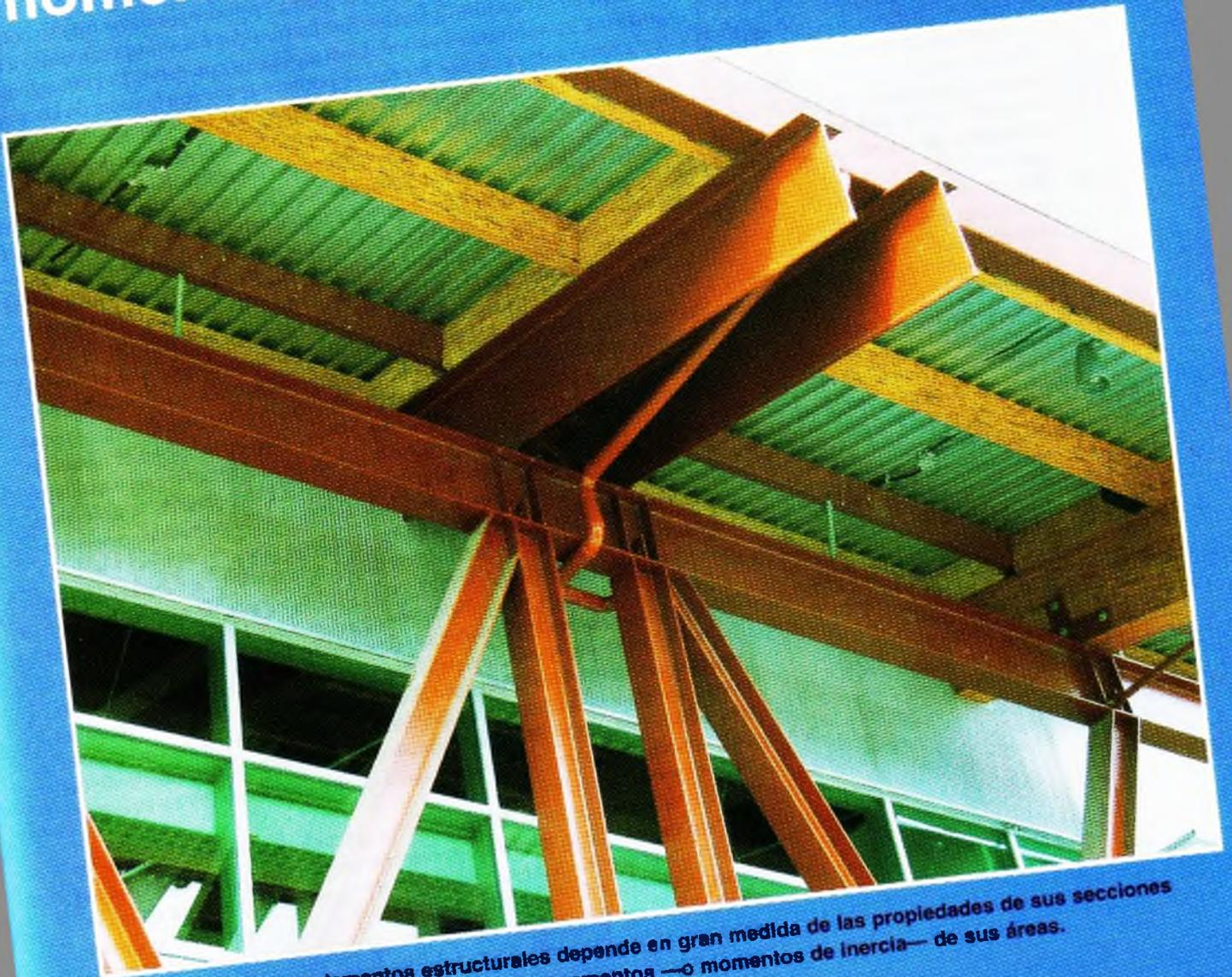
La resistencia de los elementos estructurales depende en gran medida de las propiedades de sus secciones transversales, en particular de los segundos momentos —o momentos de inercia— de sus áreas.
