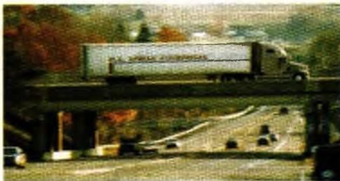
Fotografía 7.2 Las fuerzas internas en el paso a desnivel varían conforme el camión lo cruza.
