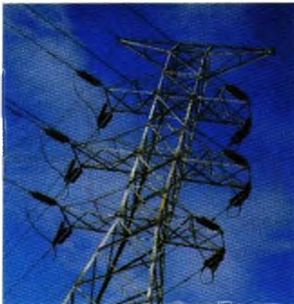
**Fotografía 6.4** Las armaduras tridimensionales o espaciales se usan para las torres de transmisión de energía eléctrica y señales en estructuras de techo y para aplicaciones de naves espaciales, como en los componentes de la Estación Espacial Internacional.
