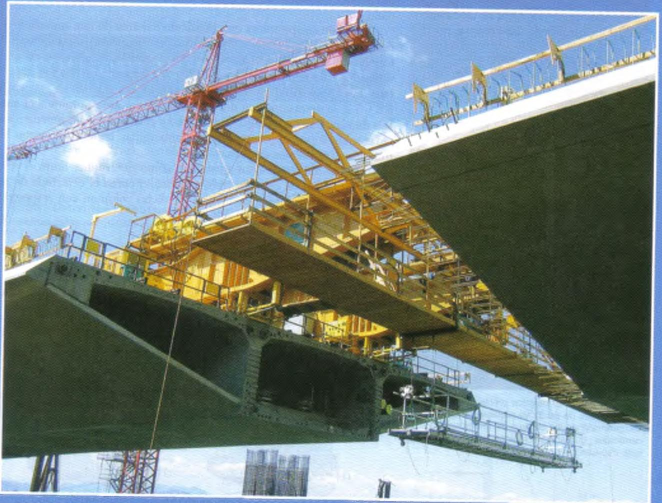
En la fotografía se muestra la construcción de un tramo del viaducto Skyway, el cual cruza la bahía que se encuentra entre San Francisco y Oakland. En este capítulo se introducirá el concepto del centroide de un área; en cursos posteriores se establecerá la relación existente entre la ubicación del centroide y el comportamiento de la carretera tendida sobre el viaducto.
