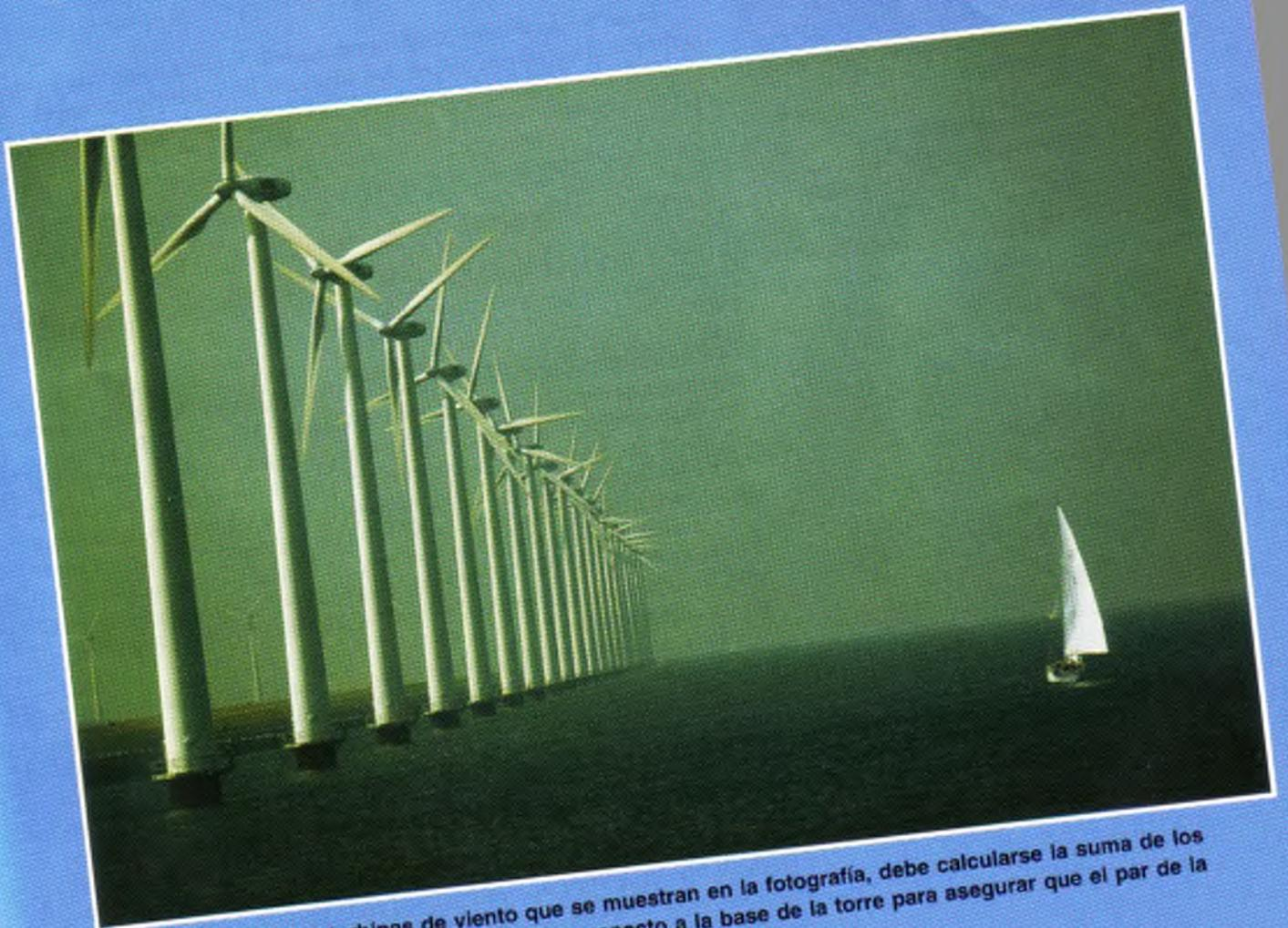
Para cada una de las turbinas de viento que se muestran en la fotografía, debe calcularse la suma de los momentos de las cargas estática y dinámica respecto a la base de la torre para asegurar que el par de la reacción en la base no produzca una ruptura en la torre.
